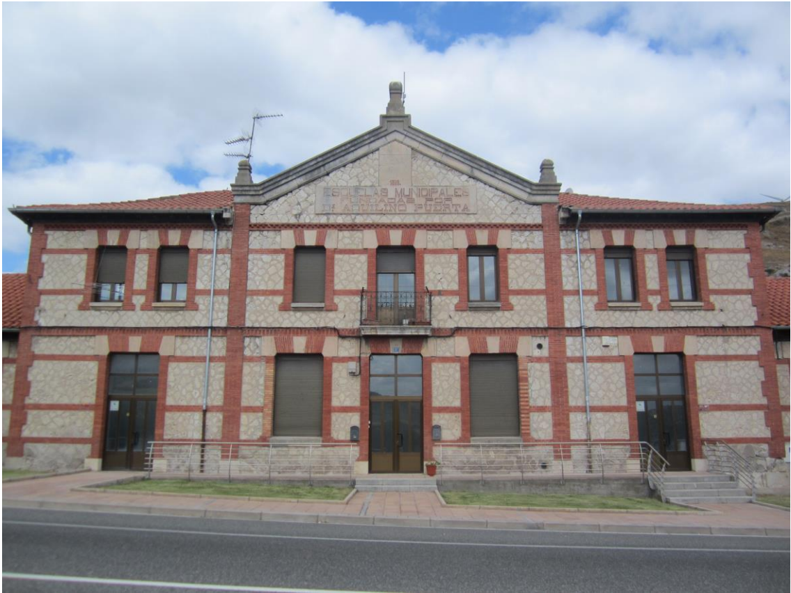
Elemento Monasterio de Rodilla Ed. Público Carretera Burgos 12
