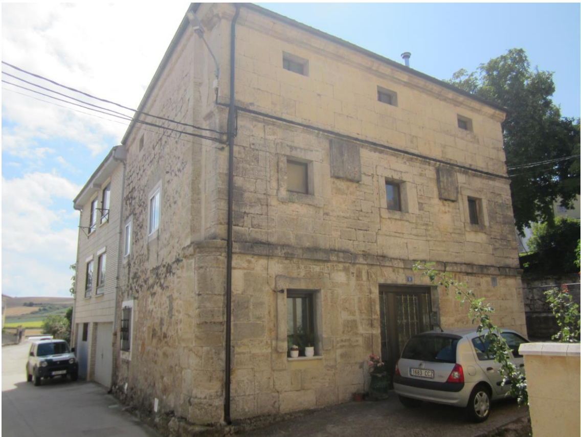
Monasterio de Rodilla Elemento Tipo de Protección Casa Calle Ctra. Monasterio a Temiño 10 Estructural
