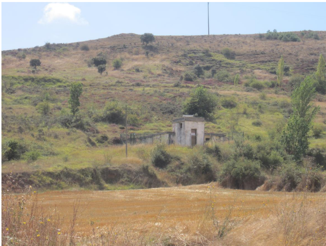
Depósito de Agua de Monasterio de Rodilla
