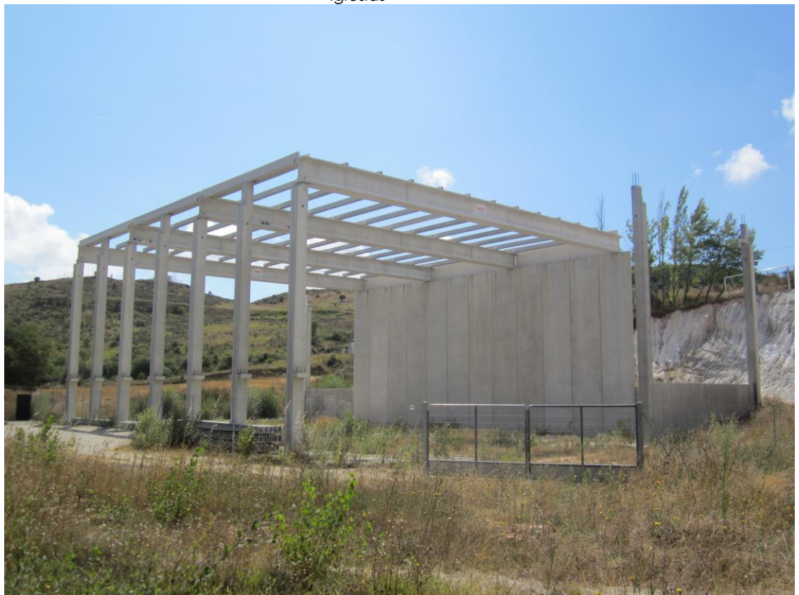
Centro Socio-Cultural de Usos Múltiples en construcción
